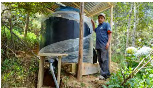
Tanque de 2500 litros instalado en parcela familiar – Com. Salabamba
