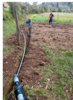
Proceso de instalación de línea de distribución de riego por goteo
