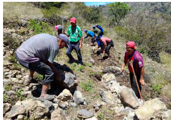
Realizando la construcción de terrazas en la Comunidad de la Congona
