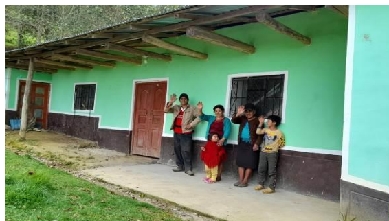
Vista de Vivienda mejorada – Comunidad de Yanapaccha
