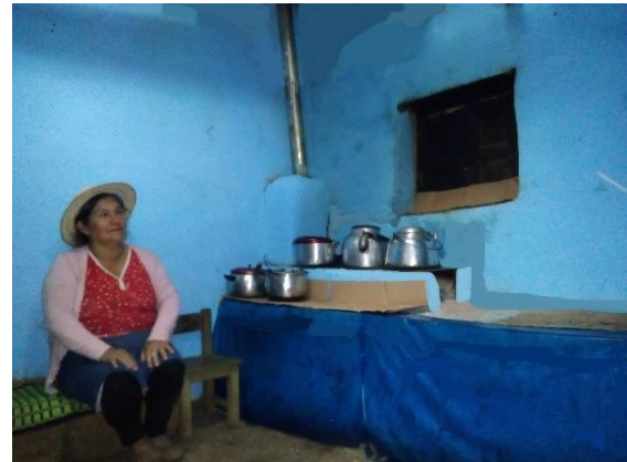
Cocina Mejorada instalada y en funcionamiento.
