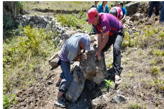
Realizando la construcción de terrazas en la Comunidad de la Congona
