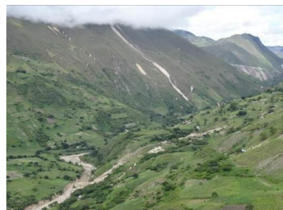
Deslizamiento de terrenos agrícolas en el caserío de Tunas Loma, San Luis de Lucma
