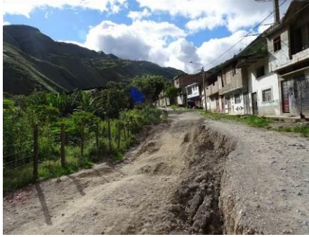
Hundimiento de la calle Carlos Fischer y su intersección con la calle Ramón Castilla en Sócota (1.2 m de desnivel y viviendas afectadas por fallas geológicas)
